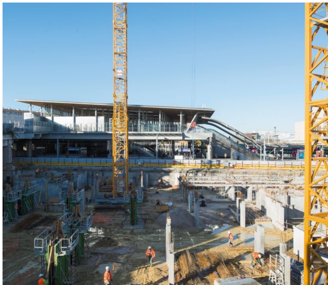
Gare multimodale de Nanterre-Université - Façade latérale
