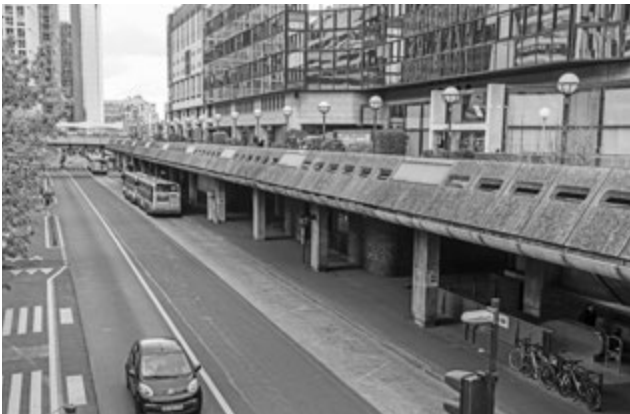
Façade rue de Bercy, état existant
