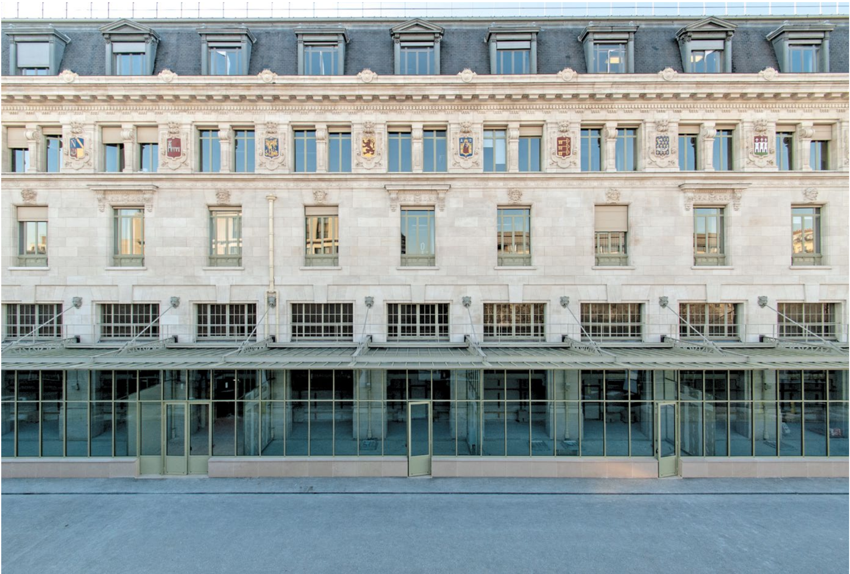
Façade « Cour Chalon » de Paris Gare de Lyon
